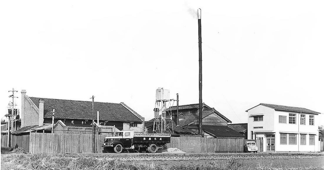
1954年頃の粟津工場
