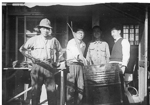
創業当初の石鹼製造風景 反応釜の代わりにドラム缶を利用していた
