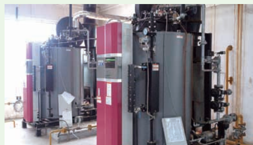
▲更新した天然ガス蒸気ボイラー
