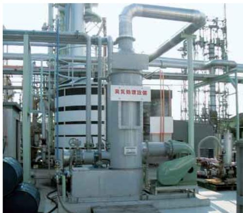
工場から発生する臭いのあるガスを集約し、処理することで臭気を大幅に削減しました。(2003年10月)
