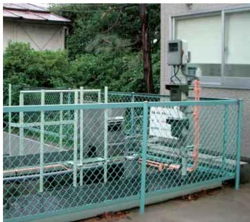
南排水槽に従来の排水計測器に加え、新たに窒素、リン、COD濃度の自動測定器を設置しました。計測データは、事務所にて常時監視およびデータ管理できるようLANケーブルにて接続しています。(2003年12月)
