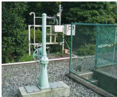
雨水排水濁度監視設備および排水槽バイパス配管。排水路へのゲート（遮断弁）、雨水排水槽への濁度モニター、pH計を設置。
