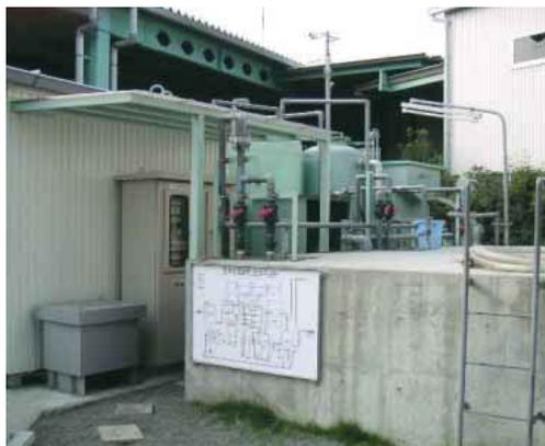
排水中の懸濁物質を凝集剤で凝集させ加圧浮上により凝集物を除去します。回収した凝集物は、フィルタプレスにて脱水し、廃棄物として処理しています。
