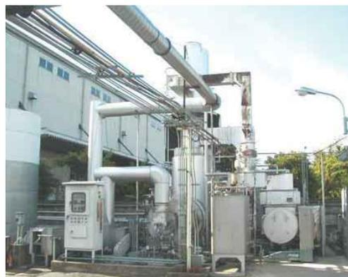
従来、反応中に発生する臭気ガスは焼却炉で焼却していましたが、廃熱ボイラーを設置することで廃ガスの熱で蒸気を発生させる熱回収を行っています。これにより蒸気ボイラーの負担を軽減し炭酸ガスの排出量削減に寄与しています。
