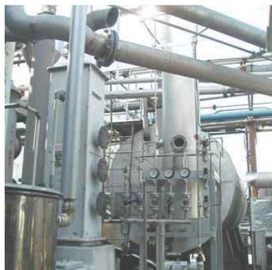
フレーカー出し時の発生ガスを霧化したオゾン水と接触させることにより、臭気成分を分解し脱臭する設備です。
