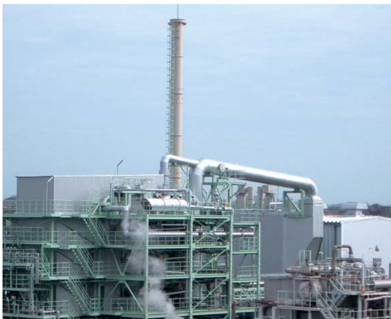
バイオマス発電設備全景
