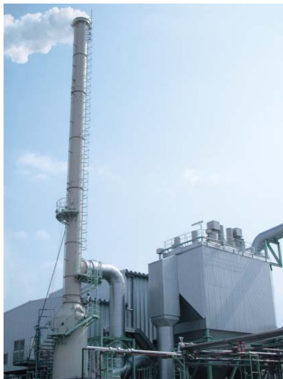
バイオマス発電設備に設置された湿式脱硫装置
