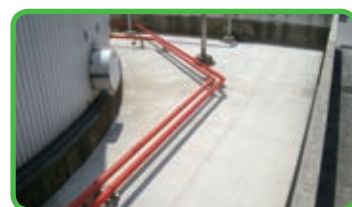
防油堤内のコンクリート化
