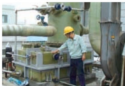
臭気除去装置を増設しました (2008.7)
