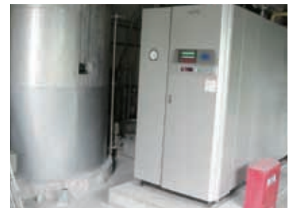
天然ガス蒸気ボイラー
