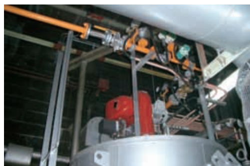
灯油用から天然ガス用に交換した配管とバーナー設備
