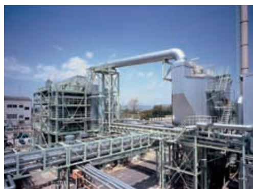
バイオマス発電設備
