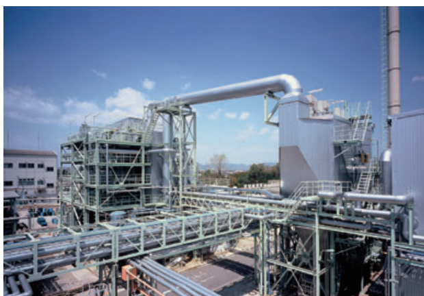
▲バイオマス発電設備
