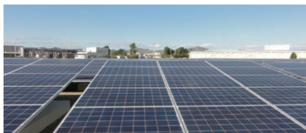
▲伊保基地に設置した太陽光パネル
