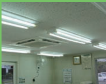
▲省エネ型照明機器への更新を推進しています(茨城工場)。
