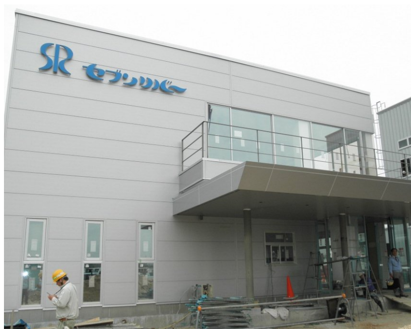
ご参考：建設中の新本社（2012年4月撮影）
